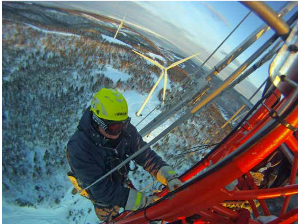
Figure 1. TechnoCentre éolien maintenance on 126-m met mast and two 2.05-MW Servion MM92 CCV (Photo credit: TechnoCentre éolien)
