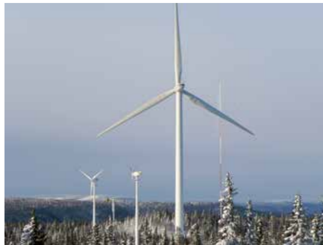
Figure 2. TechnoCentre éolien research wind farm 2.05-MW Servion MM92 CCV; Eocycle Technologies EO-25/12 direct-drive, 25-kW wind turbine; 126-m met mast (Photo credit: TechnoCentre éolien)
