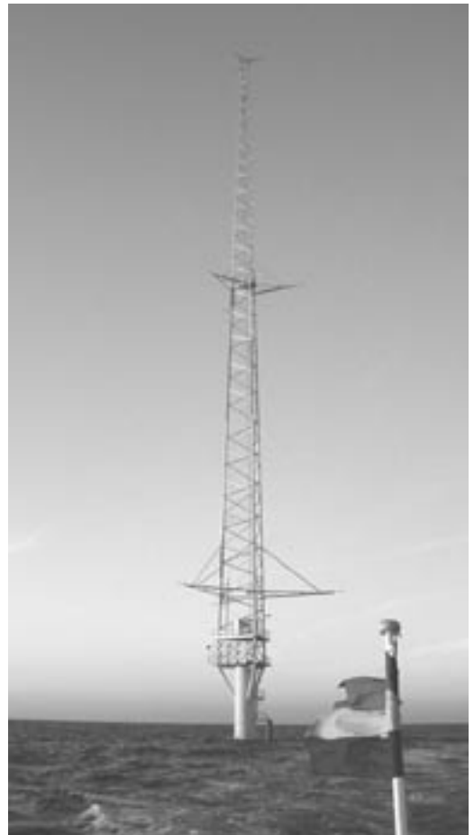
Figure 14.5 Met mast NoordzeeWind
